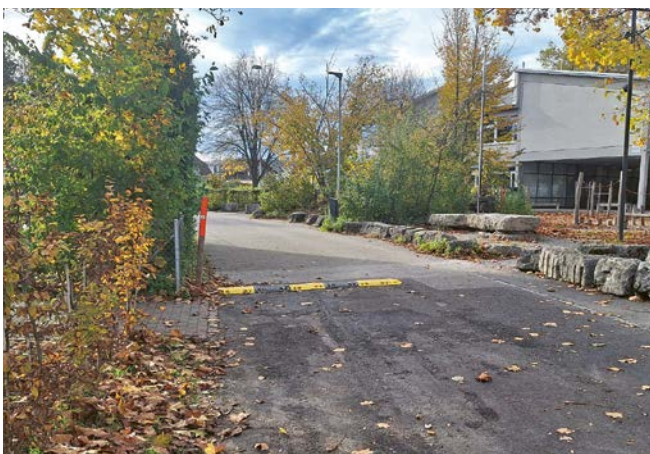
Schranke und Temposchwelle an der Isegüetlistrasse in Oberentfelden
