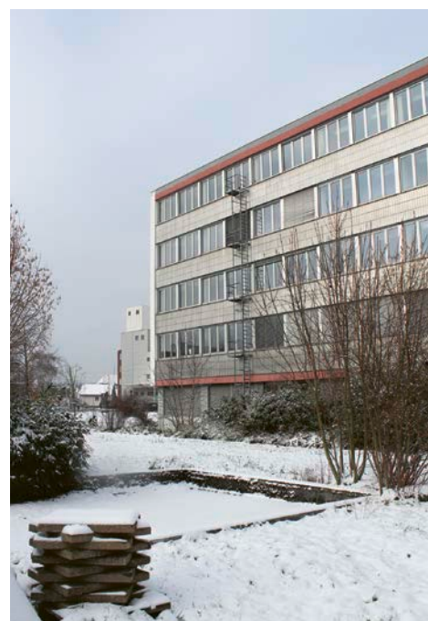
Südseite des Gebäudes mit Pausenareal und Zugang. Die Arbeiten im Aussenbereich erfolgen sobald dies die Witterung zulässt.
