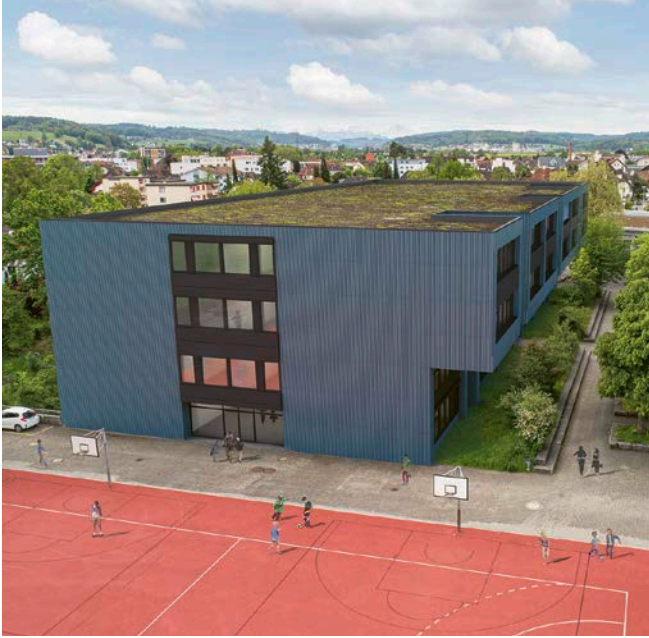
Aufstockung Blaues Schulhaus
