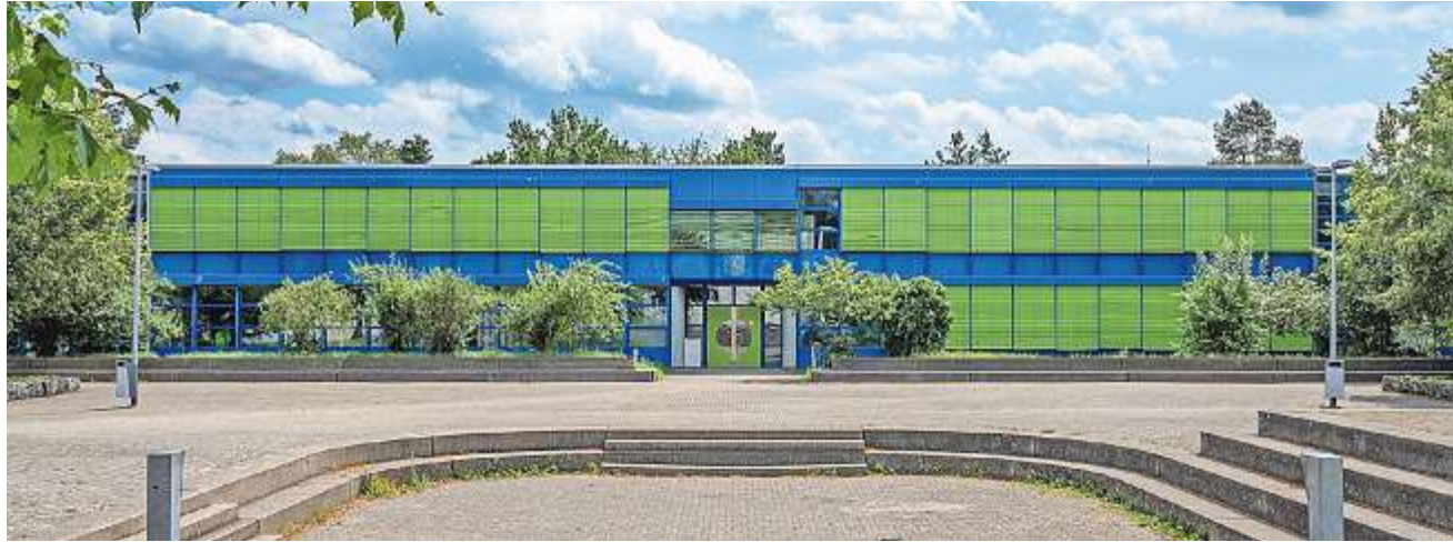
Ist sanierungsbedürftig und bietet zu wenig Platz: Das heutige blaue Oberstufenschulhaus in Oberentfelden.
